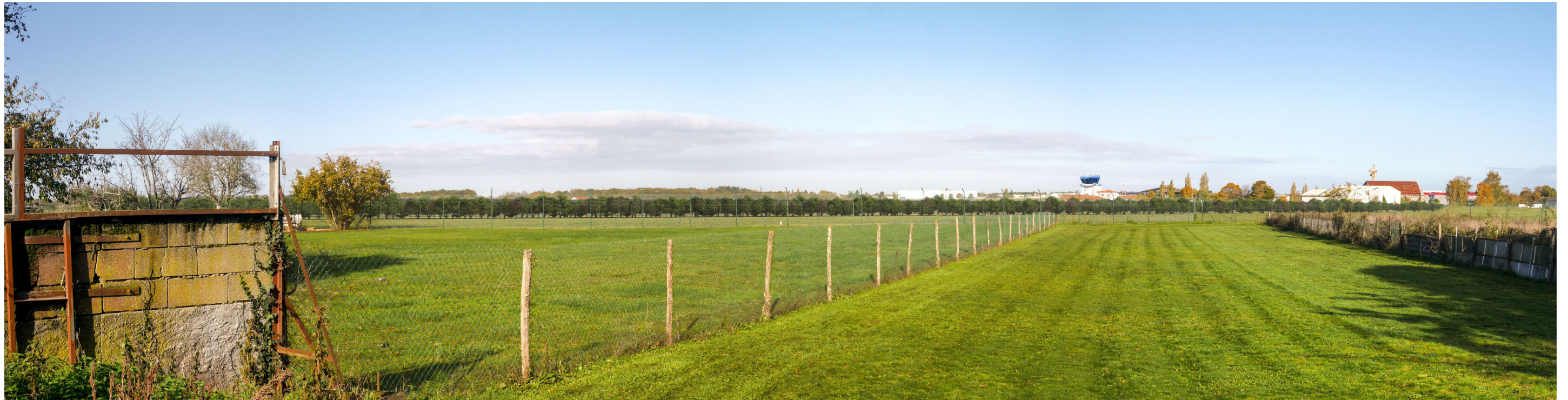
Depuis cet autre jardin, les structures photovoltaïques sont largement masquées par la haie dont l'efficacité est nette et renforcée par le recul des panneaux
